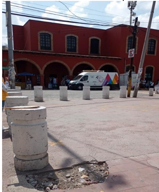
Fotografía 28. Pilotes ubicados en escuela primaria Leona Vicario.
